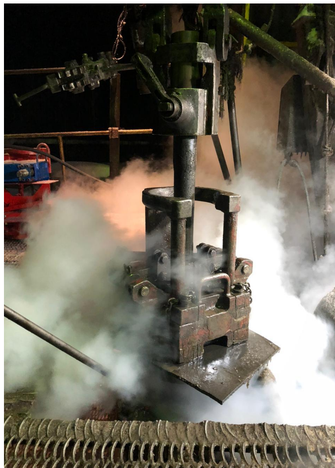
Очистка устья скважины
